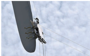
高所での危険な点検作業をロボットが代わりに実施
