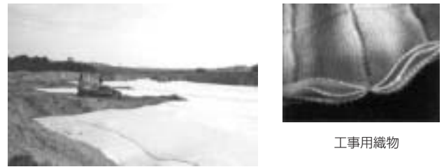
施工工事風景
