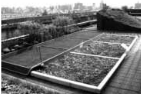
写真1 屋上緑化の様子（平成14年8月）
