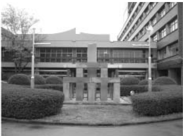
写真1 西が丘庁舎正面玄関前 モニュメントをはさむように設置された小型風力太陽光発電装置
