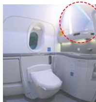
図2 プラスチックミラーの設置状況
