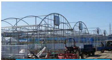
主要骨材の工場組立て現場工期を短縮
