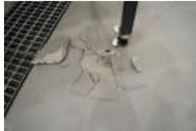
コンクリートの破壊 (雷インパルス耐電流試験)
