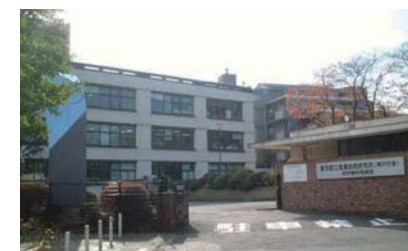
旧駒沢庁舎(東京都立アイソトープ総合研究所)
