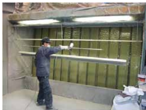
図2.1.4.1 ハンドスプレーによる塗装作業
