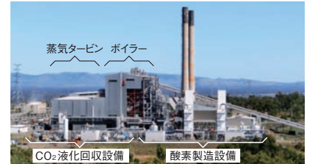
実証実験を行ったオーストラリア・ カライドA発電所4号機
