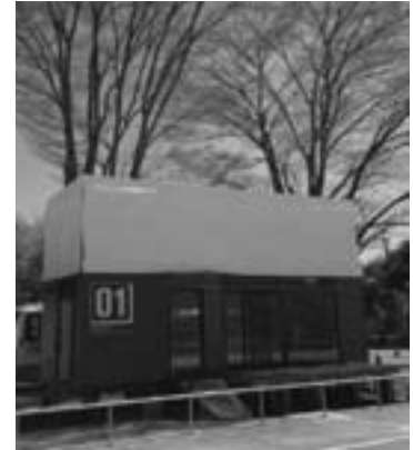
図1. 設置時に2階建てに展開された状態
