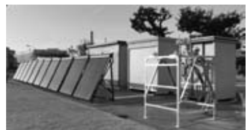
図 4. システム全景
