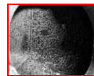
図2 ダクト内のヤニ
