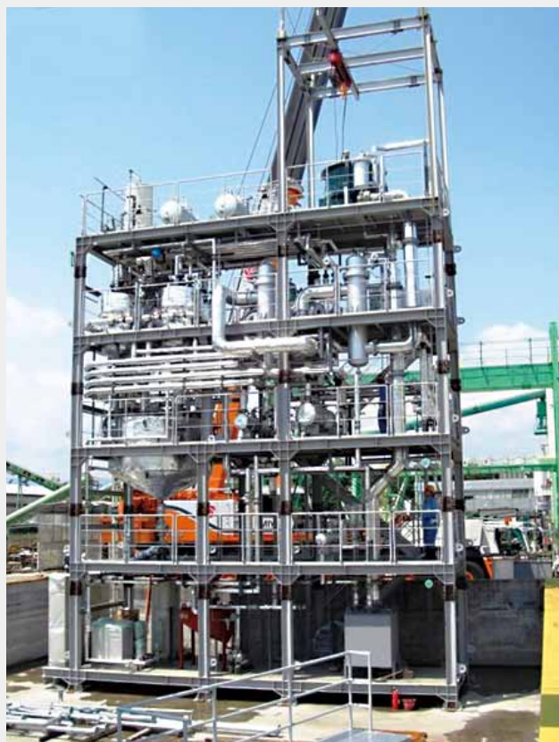
セシウム除染技術を実用化した実証実験プラント。製品開発支援ラボでの研究・実験の成果でもあります。
