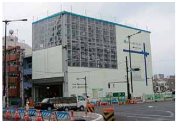
図4 採光パネルを使用した仮設防音ハウス
