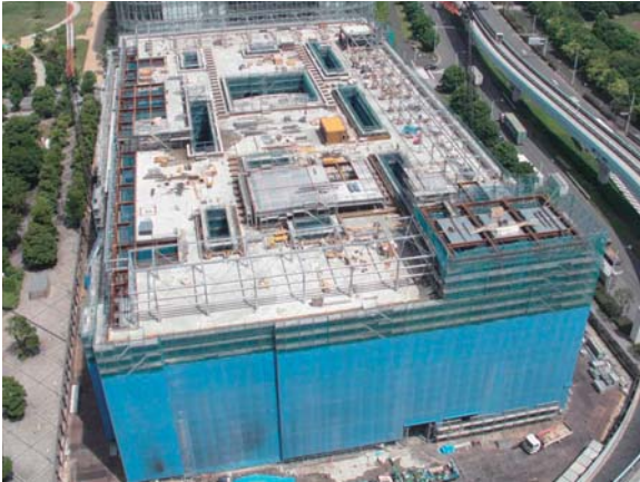
図1 新本部建設現場全景 (H22.6.15撮影)
